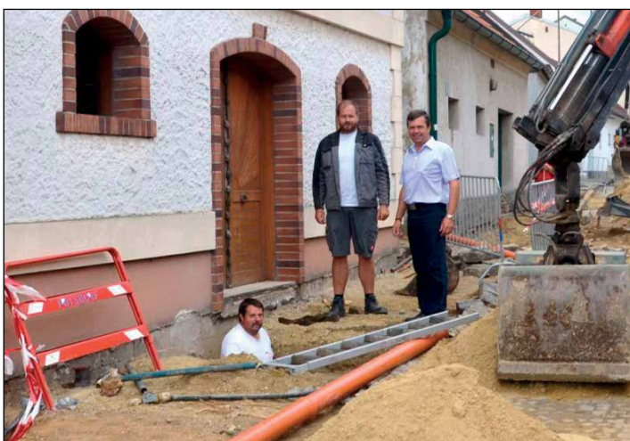
SANIERUNG: In der Großen Kellergasse in Wetzelsdorf wurden im Zuge der Gehsteigsanierung auch die Wasserschieber und die Regenabflussrohre erneuert. Die Gemeinderäte Andreas Stoiber und Heinz Bauer überzeugten sich vom Baufortschritt.
