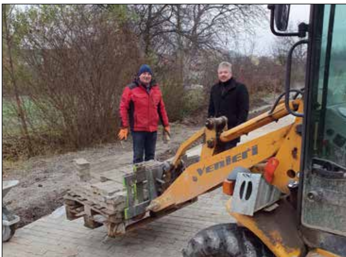
Befestigung für neue Parkmöglichkeiten in der Adolf-Schwayer-Gasse. Bürgermeister Thomas Grießl freut sich über die Tätigkeiten des Bauhofs.
