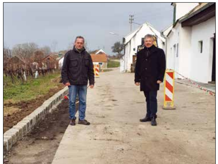
Kellergasse Grundern – Entwässerung und Straße erneuert! Bürgermeister Thomas Grießl dankt Ortsvorsteher Sigi Denner.
